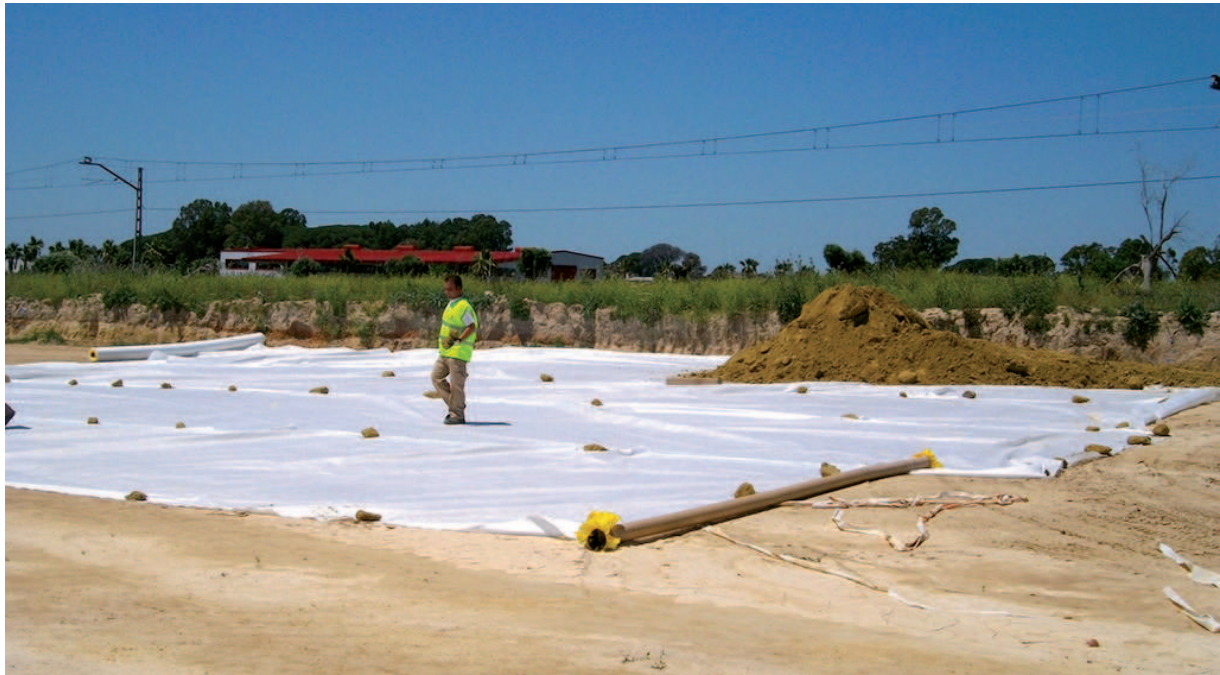
Fig. 3. Cubrición de la parte afectada de “Canal de Guadalcaén II”.
